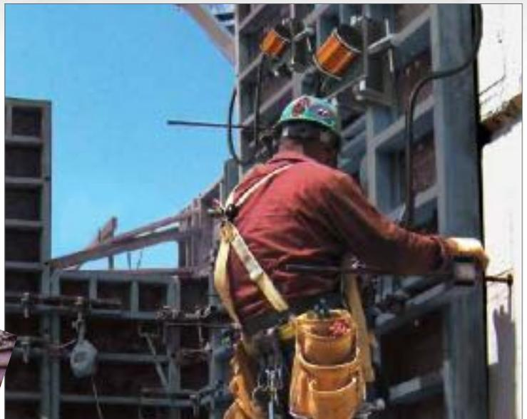
El modelo SVRX-4000 estándar de VIBCO ofrece hasta 8" de penetración por vibración a entre 9 y 11000 VPM. Con una presión de aire de 80 a 120 PSI, el SVRX 4000 produce 4000 libras de potencia. La lubricación es necesaria para una larga vida útil. Consulte acerca de los lubricadores en línea de VIBCO.
