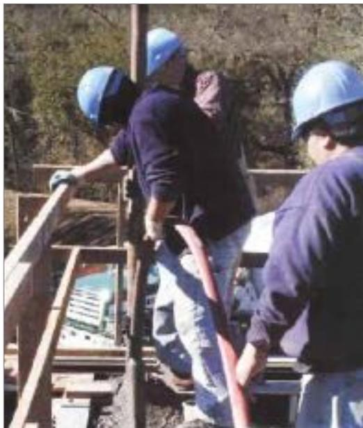
Arriba: Un vibrador interno Modelo KA, con su diseño patentado de ahorro de aire, brinda un rendimiento de alta frecuencia y alta potencia con el menor consumo de aire.
